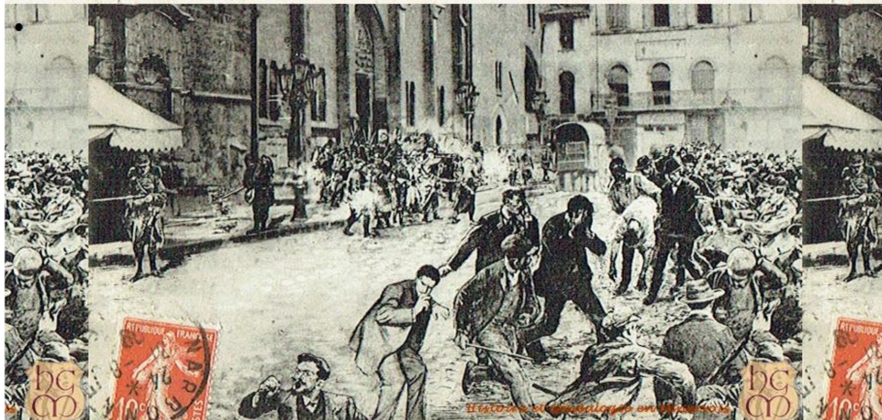
TROUBLES VITICOLES — La fusillade du 20 juin, place de l'Hôtel-de-Ville, à NARBONNE
